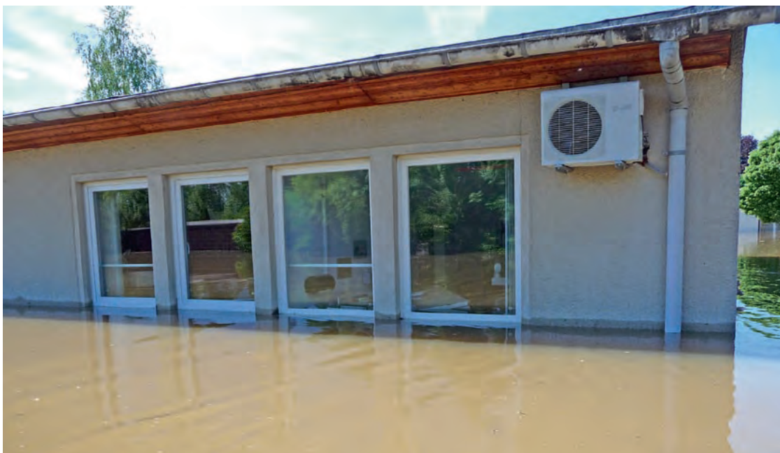
Keine Chance auf Rettung: Das Wasser stand bis zu 1,30m hoch in den Praxisräumen.
